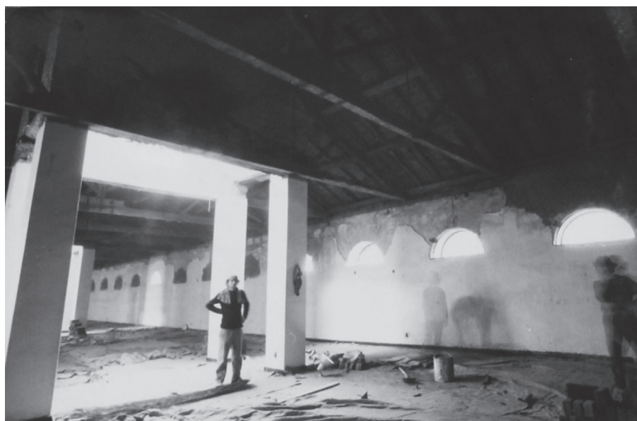
Sala Pintores colombianos muertos. Parte de ventanas tapiadas (mayo 1976)
