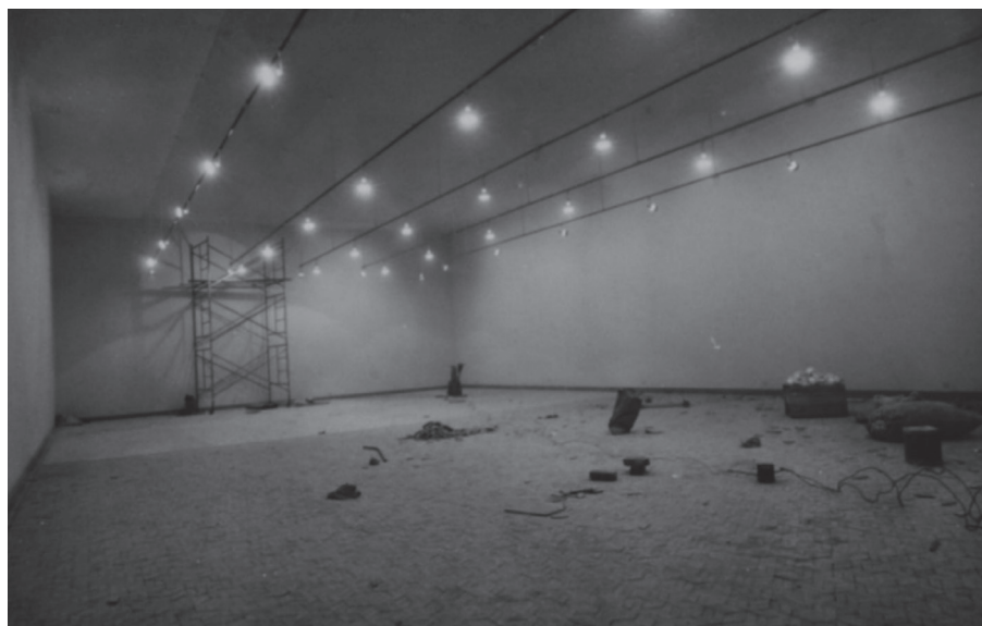
Sala de Exposiciones primer piso con los reflectores instalados (mayo 1976)
